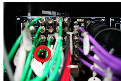
中継車外側のメンテナンスドアを開けて望んだ、VE ラック下部に搭載されたカメラコントロールユニット HDCU-5500 の背面端子側。CCU 背面に備えられたリアタリ (赤丸内中心部) が確認できる。
