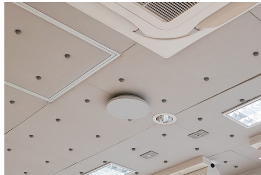
教員卓上方の天井に設置されたビームフォーミングマイクロホン。移動する教員の声を広範囲に收音
