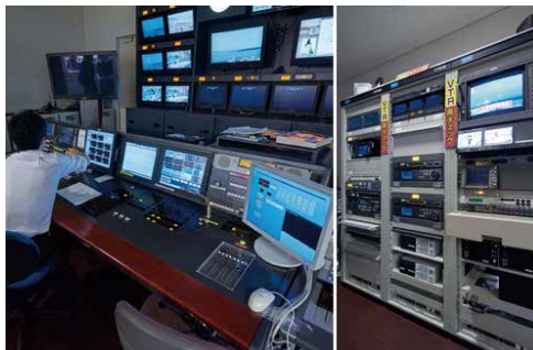
XDS サーバー送出システムを導入したニュースサブ。上位の運行システムとのデータ連携で、より効率的で安定したオンエアを目指しています。地域の日々の情報を伝える昼のストレートニュースや夕方の県民ニュースなどにフル稼働中です。
