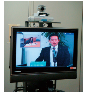
テレビネットワークシステム (TNS) は、創業100周年記念プロジェクトの一貫として構築された
