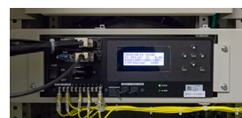
BMU(バッテリーマネジメントユニット)HUB。8台のBMUを統合している。
