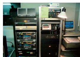
送出用のHDCAMを納めた制御用ラック。
