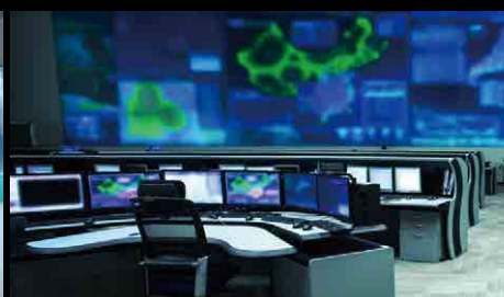
コントロールルーム
