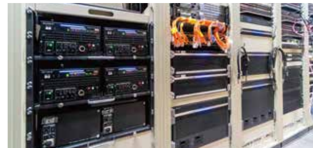
ラック内のCCU、IP関連機器とスイッチャー本体
