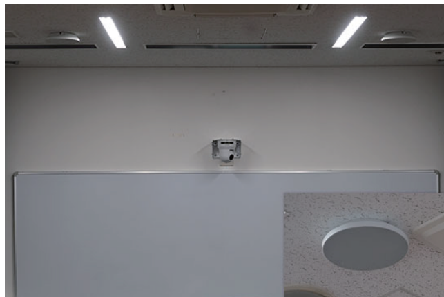
ホワイトボード上に設置された学生撮影用カメラと拡声用の天井設置型マイク
