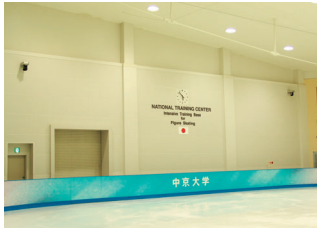
アリーナ4隅の壁面に設置されたBRC-H700。プロジェクターを使って200インチスクリーンにハイビジョン表示することも可能。また、最大12台まで拡張できるように配線されています
