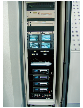
4台のBRC-H700を1台のリモートコントロールユニットRM-BR300で操作。収録デッキとしてXDCAM HDレコーダーPDW-F75を4台配備しています。音響面でも最大4人まで異なる曲で演技できるワイヤレスイヤホンシステムや、選手自身で操作が可能なようにボタンを押してから20秒後に演奏を開始するディレイ装置などを採用。効率的な練習をサポートしています
