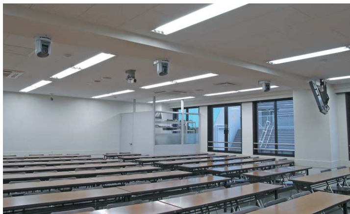
講師の動きを追うカメラと黒板の文字を明確に撮影するカメラの合計3台で運用しています。
