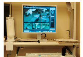
全カメラ映像を1台のモニターに分割表示。スタッフステーションや医師控室から、全室の進捗状況がひと目で把握できる。
