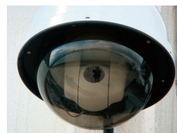
83台の回転型ネットワークカメラ SNC-RZ50Nを施設内に設置。全てのカメラをドームハウジングに収容している。
